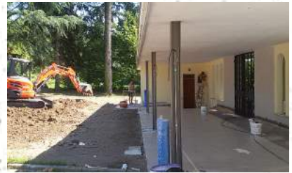
Den ganzen Sommer über wurde gebaut.
